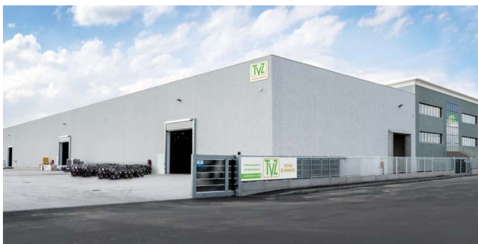
► A Carpenedolo, Brescia, sorge la nuova sede TVZ: 7.000 metri quadri dove trovano spazio una palazzina uffici, in cui sono riunite le attività di progettazione, logistica, uffici amministrativi, vendite e marketing e un'area produttiva tecnologicamente avanzata per la realizzazione e l'assemblaggio di assali e sospensioni
